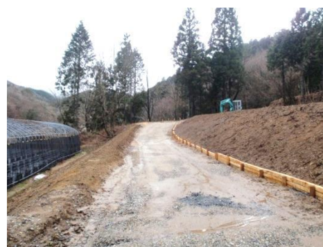
現場写真（作業道：駒ヶ原②線）
