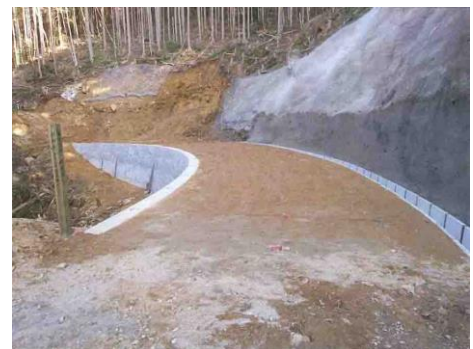
林道笹頭山線 開設状況
