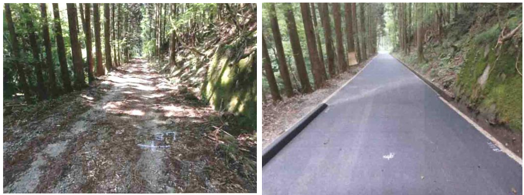
林道境川線 舗装状況
